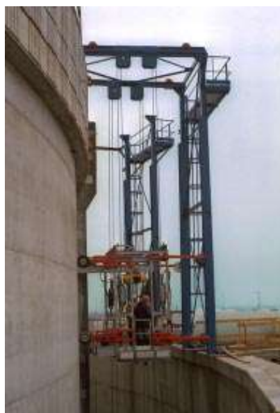
Platforma z wytworzonym napięciem wstępnym, wyposażona w hydrauliczną wciągarkę TIRFOR TU-32H
